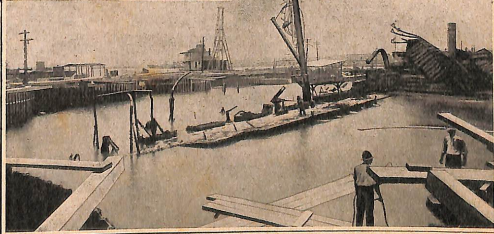
De puissantes pompes emplirent les caissons de sable et de vase qui devaient rendre étanche l'emplacement du navire.
