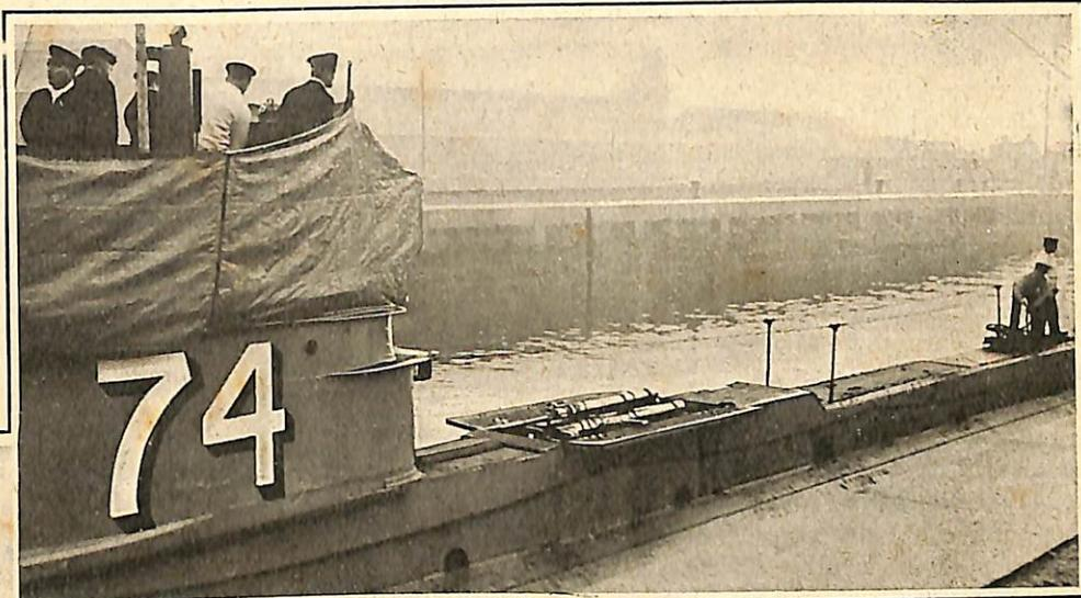
Les panneaux en s'ouvrant laissent apparaître le canon renfermé dans la coque du navire.
