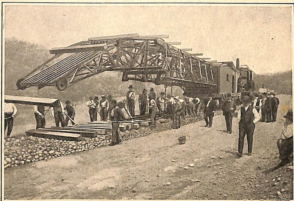
Cette machine comporte plusieurs wagons et plates-formes et tout un système de courroies sans fin qui font avancer traverses et rails à mesure que le ballast est prêt.
