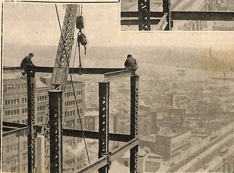
Sans songer au vertige, ces ouvriers fixent la solive à chaque bout avec des boulons.
