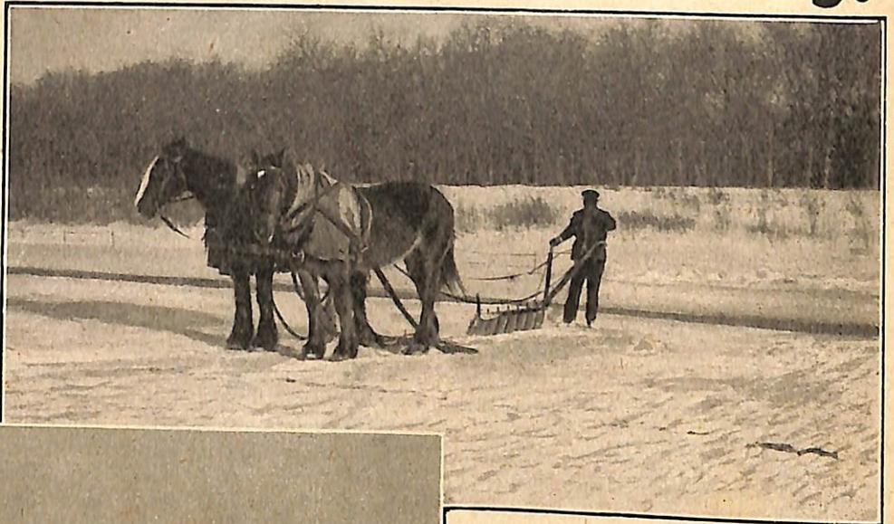
Avec une machine semblable à une charrue et pourvue de socs on découpe profondément la glace.
